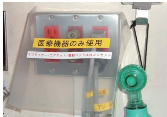
コンセントが破損している場合は、電源を差し込んだ時にショートし停電ことがある。日常の点検・管理を行い、破損した場合は早急に補修、交換を行う。保安回路は医療機器専用とし、入院患者が使用しないよう、保護キャップをするなど明示することも必要である。
